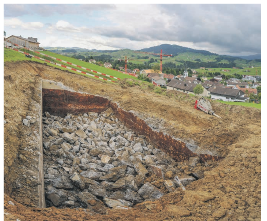
Das Schicksal des Reservoirs Brunnhalde oberhalb des Dorfes Waldstatt soll sich in Haslen beim Reservoir Unterchristes nicht wiederholen. (Archivbild: Hans Ulrich Gantenbein)
